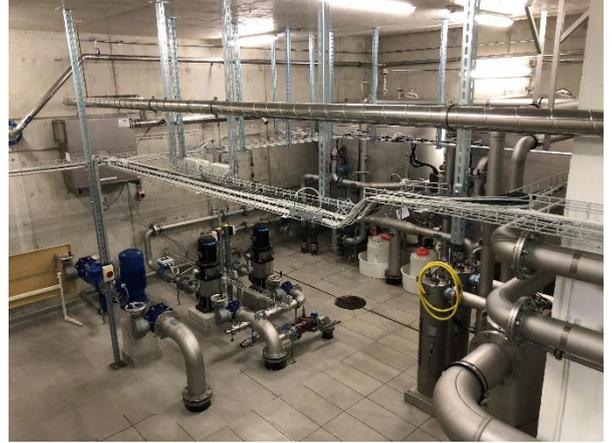
Figure 6 Installations de déferrisation situées au réservoir de Montillier
