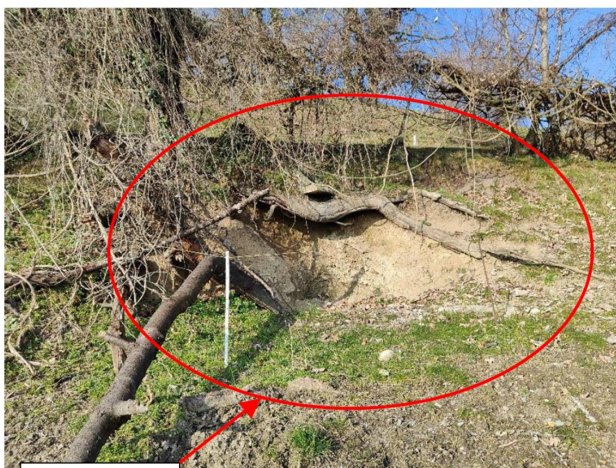
Talus à stabiliser
