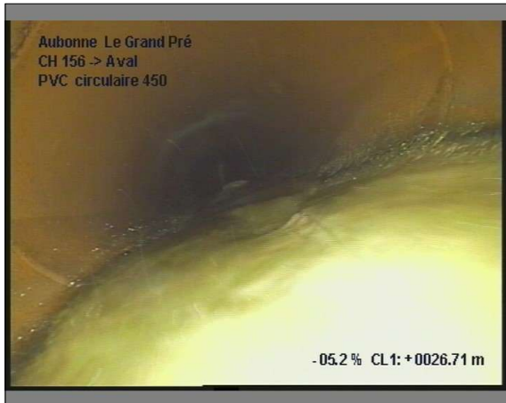
Photo: 1_4A, 00:02:34 26,7m, Etat général, selon photo
