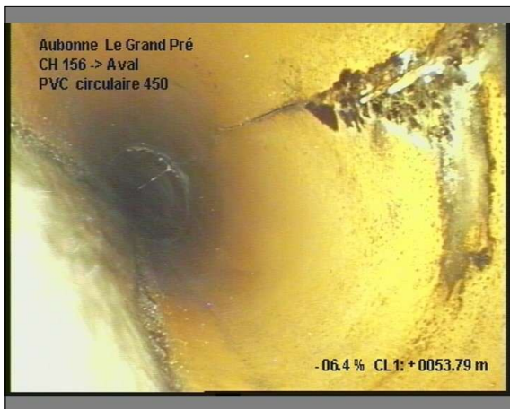
Photo: 1_14A, 00:06:49 53,7m, Etat général, selon photo
