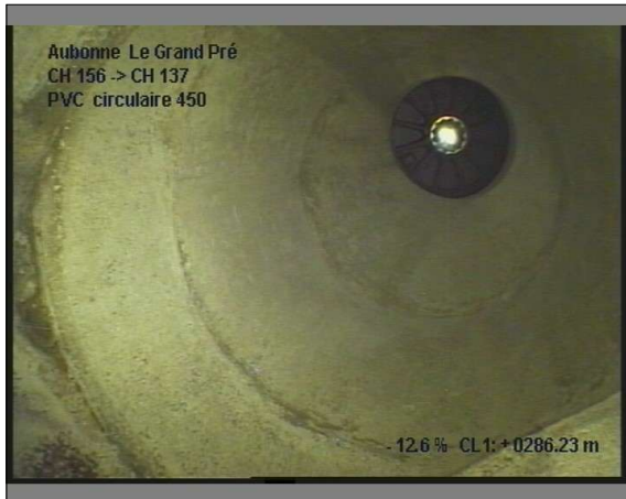
Photo: 1_39A, 00:29:39 286,2m, Fin du tronçon
