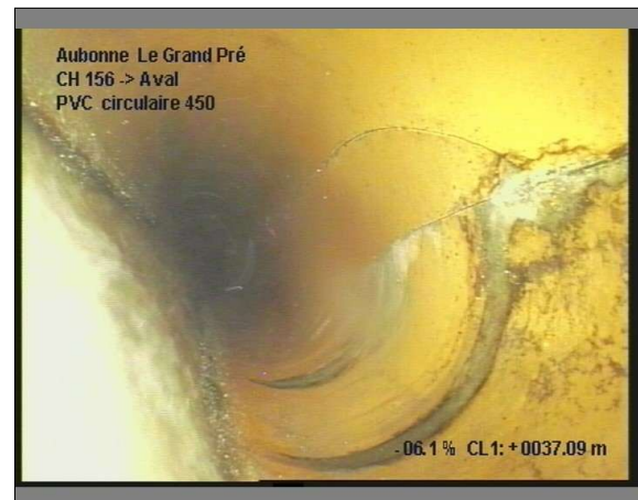
Photo: 1_9A, 00:05:01 37m, Etat général, selon photo
