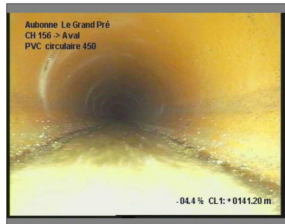
Photo: 1_33A, 00:16:16 141,2m, Etat général, selon photo
