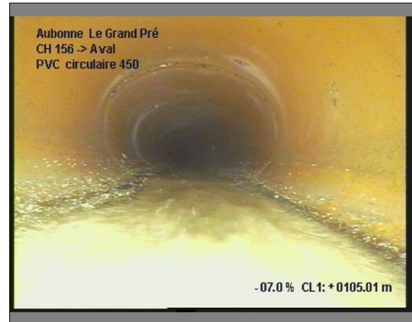
Photo: 1_31A, 00:13:56 105m, Paroi du tuyau, déformée de 12 à 12 h.
