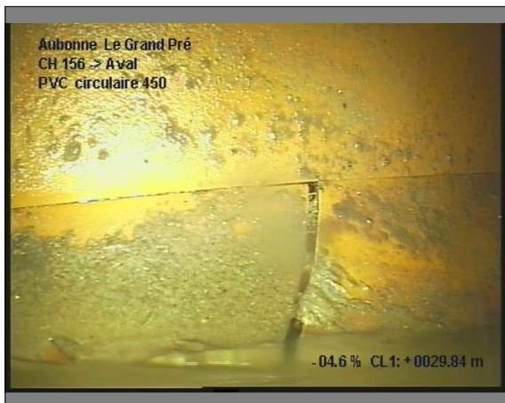
Photo: 1_5A, 00:03:25 29,8m, Etat général, selon photo
