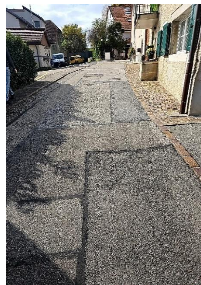
Rue du Carre
