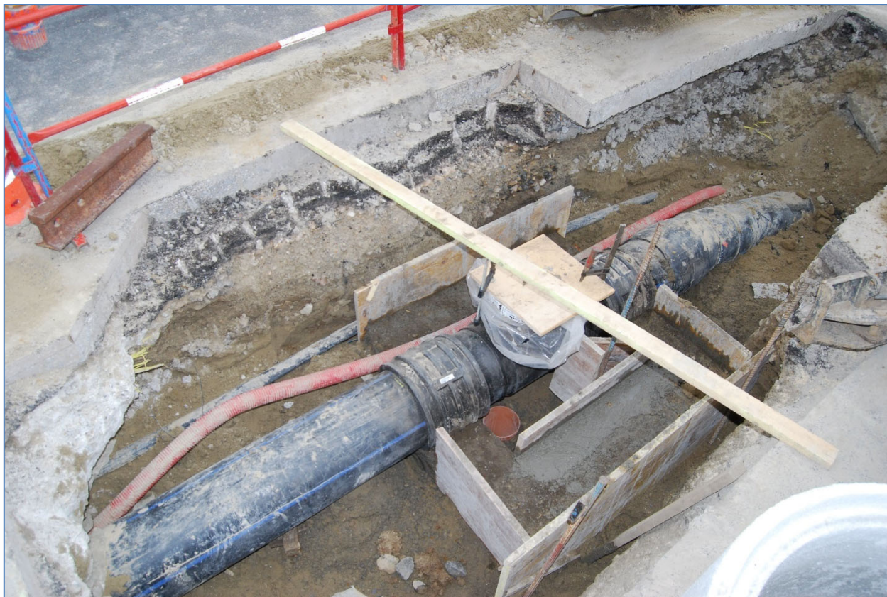
Figure 2: Chambre de curage en cours de construction
