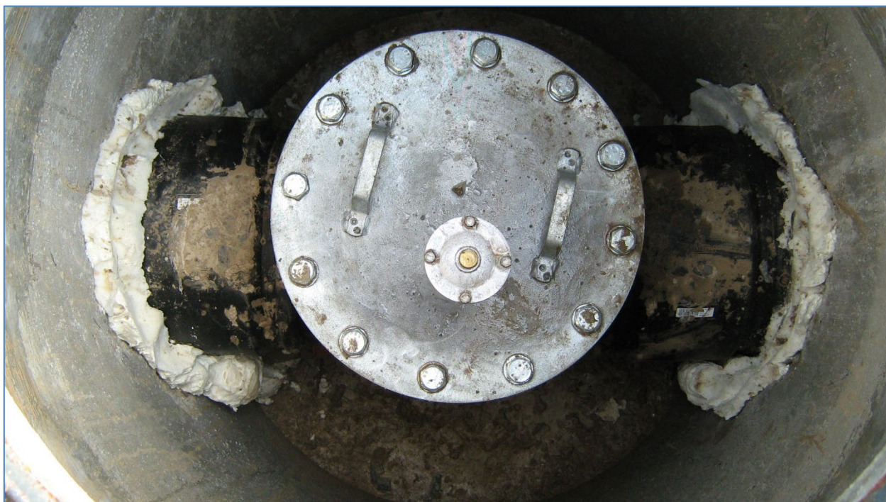
Figure 3: Chambre de curage terminée
