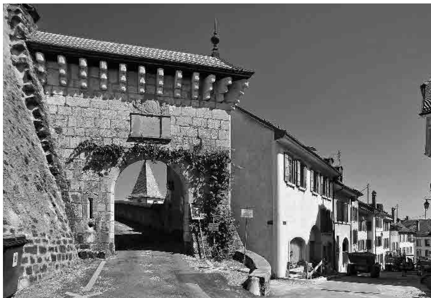
30 Porte fortifiée, vers 1500, accès au château au sommet
