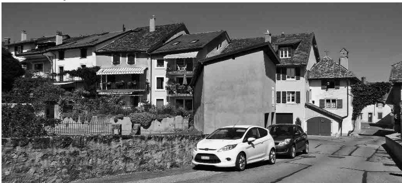
9 Accès au niveau de la porte de Bougy, reconstr. 1759, par le « pont », att. 1729
